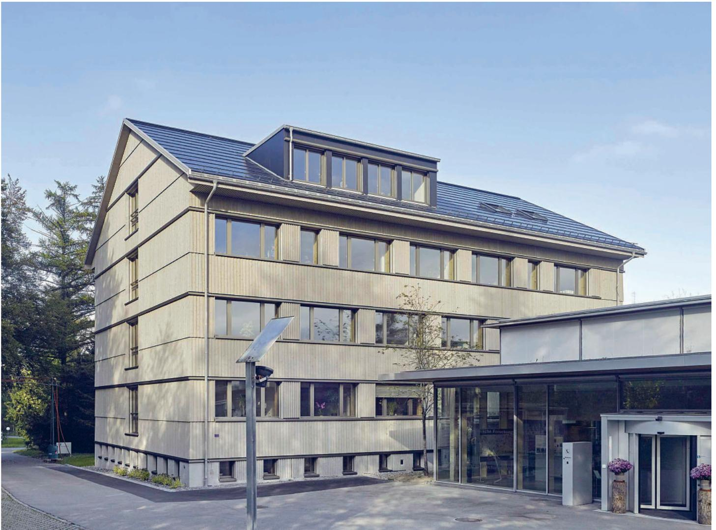
Das sanierte Gebäude der Eidgenössischen Forschungsanstalt für Wald, Schnee und Landschaft (WSL) ist mit einer 750 m<sup>2</sup> grossen PV-Anlage ausgerüstet und nach Minergie-A-ECO zertifiziert.
