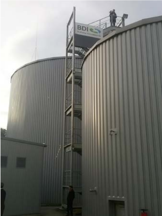
Abbildung 4: Kontaktverfahren zur Vergärung von Brauereiabwässern (Hauptfermenter hinten; Fermenter mit Schlammabscheider vorne) (Foto: BOKU, Wien)
