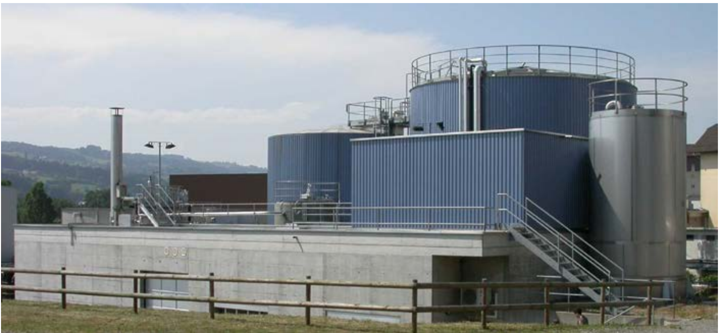
Abbildung 5: Aufbereitung von Abwasser aus der Babynahrungsproduktion in einem Anaerobfilter (Foto: Triple E&M)
