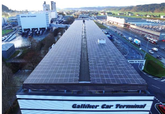
Die PV-Anlage deckt den Energiebedarf des Gebäudes ab und kann zusätzlich 148 Elektroautos mit Strom versorgen.
