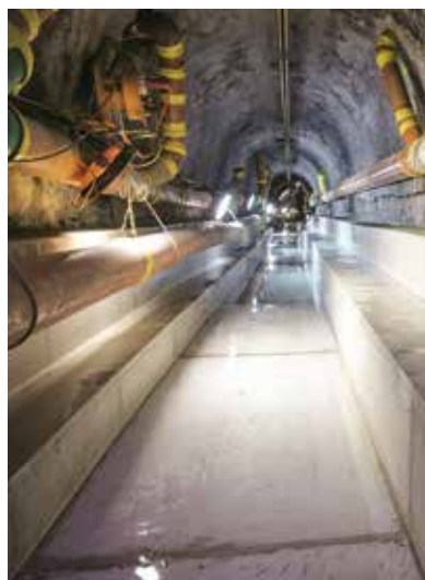
Abwasserkanal mit Sohlenwärmetauscher
